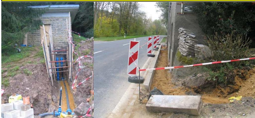
Die Arbeiten zur Verlegung einer neuen Wasserleitung bis nach Bollendorf-Pont und Weilerbach und der Anschluss der Héliar ans öffentliche Wassernetz sind so gut wie abgeschlossen.
