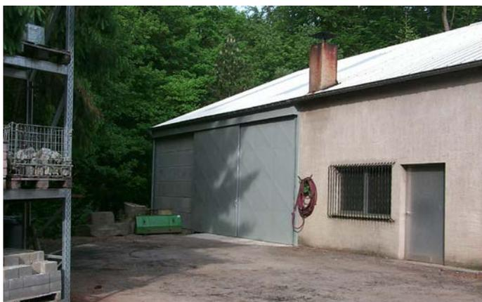
Die technische Halle im Centre Martbesch wurde seitlich vergrößert. Es handelt sich hier um eine Fertighalle welche auf eine Betonplatte installiert wurde. Dieser Anbau dient zum Lagern von Arbeitsmaterial, sowie als Unterstand für das Material welches bei den Waldfesten benutzt wird. Definitiver Kostenpunkt: **27.713,71 €**
