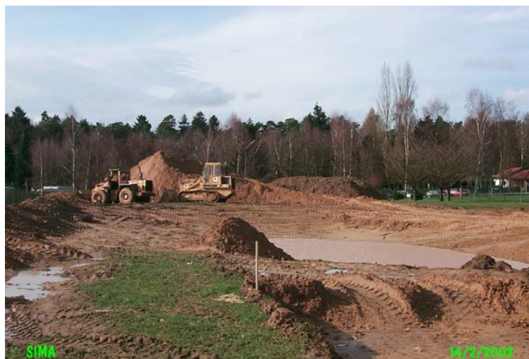
Chantier hall sportif
