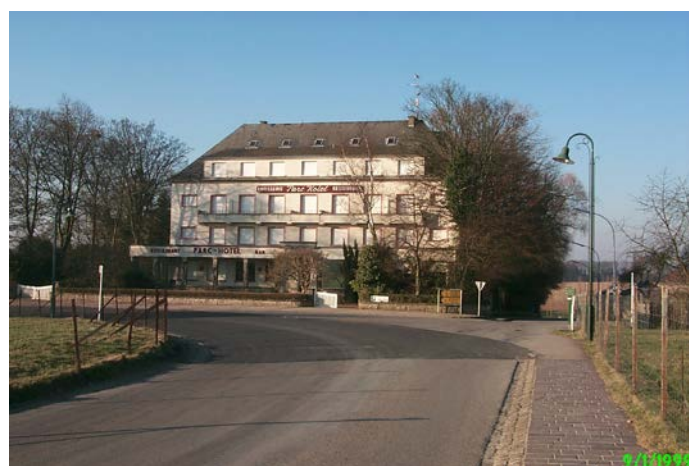
Aménagement de la bifurcation près du Parc-Hotel
