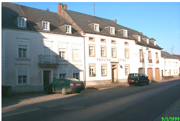
Démolition de la Maison Bingen Stirn
