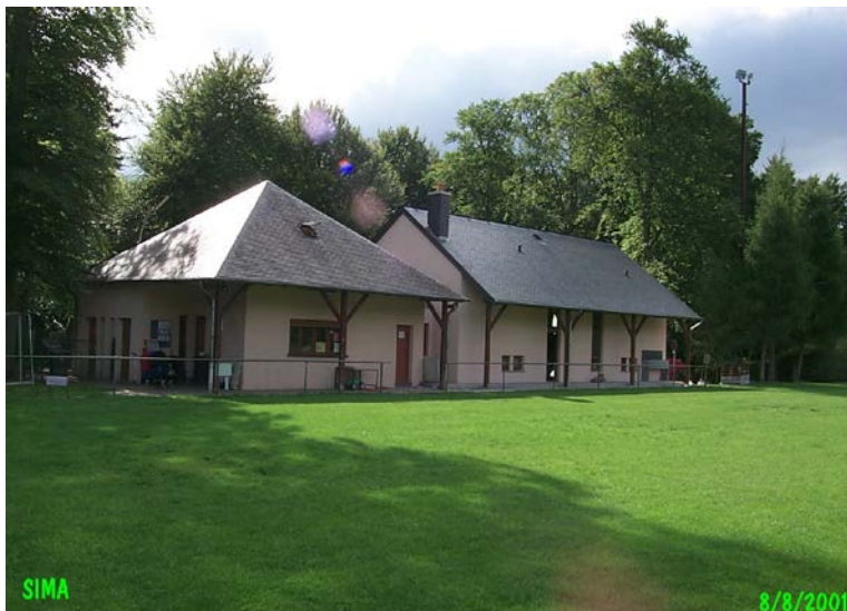
Achèvement des travaux au bloc sanitaire près du terrain de football
