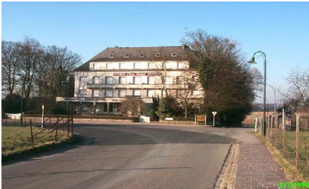
Instandsetzung der Gabelung beim Parc-Hotel Aménagement du croisement près du Parc-
