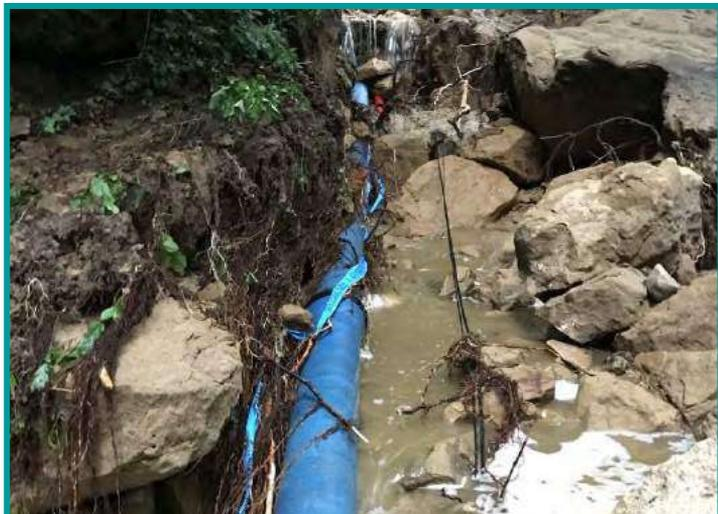
Eine Beschädigung durch Felsbrocken stellt eine stete Gefahr dar. Zudem ist die Glasfaserverbindung an mehreren Stellen gerissen und der Zugangsweg zu den Quellenfassungen existiert nicht mehr.
