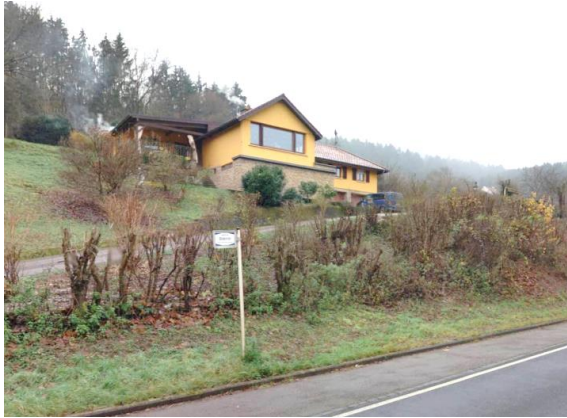
N° 23, situé au Nord du site Source : Cyclomedia, mars 2019
