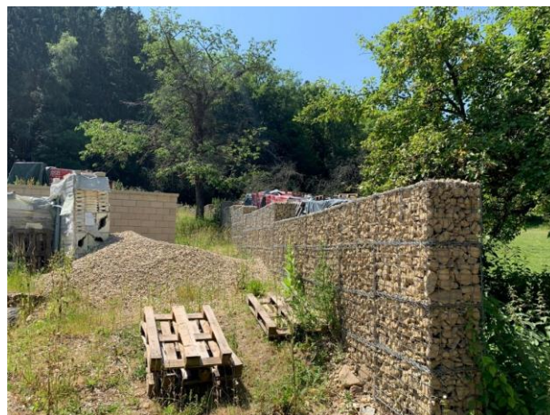
Vue n°5 : mur de gabions implanté le long de la limite Sud-Est du site
