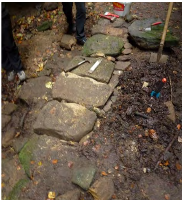
Figure 5. Couvertines remises en place
