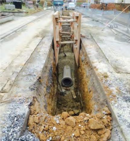
Von Januar 2015 bis Ende März 2015 wurden in der Straße „an der Ruetsbech“ Bauarbeiten an dem Abwassernetz der Gemeinde durchgeführt. Einerseits wurde eine Regenwasserkanalisation zur nachhaltigen Entwässerung mittels Trennsystem verlegt und das vorhandene veraltete Schmutzwasserrohr durch eine größere und abflussstärkere Leitung ersetzt.
