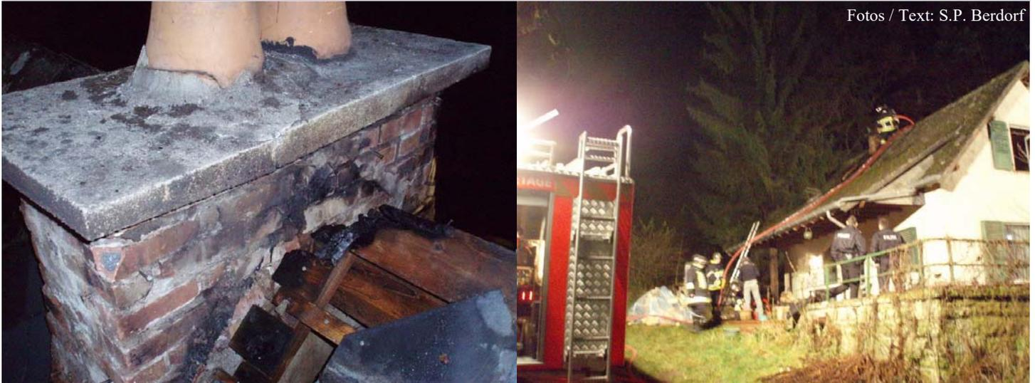
Der Kamin hatte sich überhitzt und entzündete durch ein Loch den Dachstuhl des Hauses. Beim Eintreffen brannte der Kamin und zum Teil der Dachstuhl. Personen befanden sich nicht mehr im Haus. Durch teilweises Öffnen des Dachstuhls konnten wir das Feuer binnen 20 Minuten löschen.
