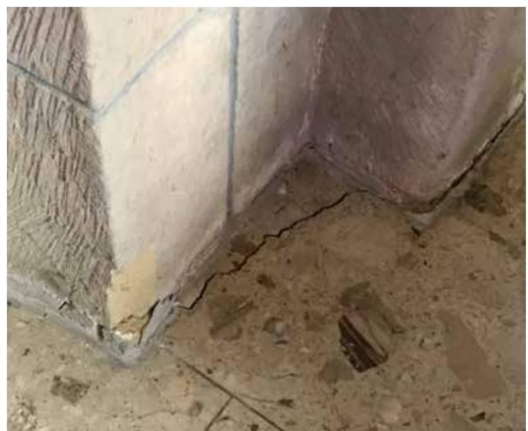
Parmi les mesures d'assainissement proposées par le bureau d'études on a choisi une méthode non conventionnelle, avec l'irrigation supplémentaire du sol à l'aide d'un détournement des tuyaux de descente le long des murs extérieurs. Ainsi on peut réduire le danger d'un affaissement futur du bâtiment. Le devis des travaux et honoraires d'ingénieurs établis par le bureau d'études Schroeder & Associés chiffré à 85.178,11 € est approuvé unanimement par les conseillers.
