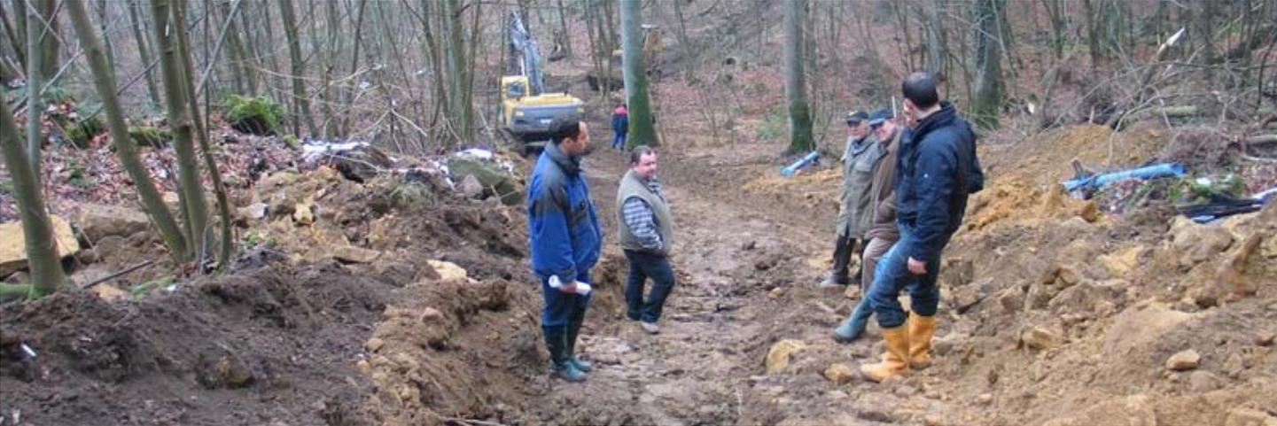
Die Wasserleitung für Weilerbach musste durch steiles Gelände verlegt werden, was für Mensch und Maschine ein schwierigeres Unterfangen war.
